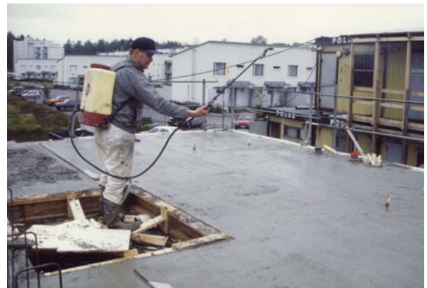
Kuva 2. Plastisten halkeamien muodostuminen tuulissa ja/tai lämpimissä olosuhteissa voidaan ehkäistä sumutettavalla varhaisjälkihoitoaineella. Varhaisjälkihoitoon tarpeeseen vaikuttavat myös tuoreen betonin vedenerottuminen ja käytetty notkistus.
