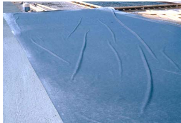
Kuva 5. Ulko-olosuhteissa varsinaisen jälkihoidon luotettava menetelmä on erilaisten läpikasteltavien kankaiden käyttö (esim. suodatinkankaat, joilla kosteana hyvä paikallaan pysyvyys).
